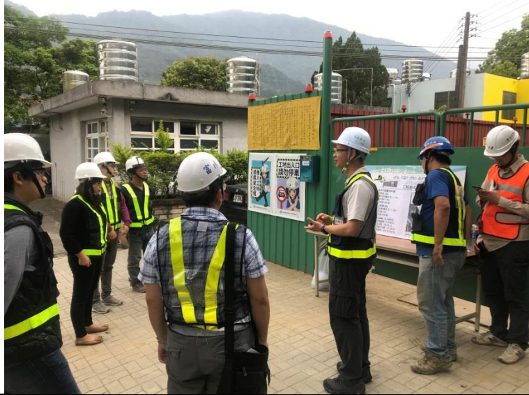
梅花地滑區整治工程(水土保持局臺北分局)
